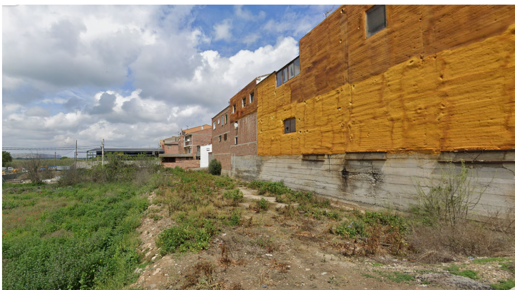
Fotografía de la parte posterior del edificio afectado por la alineación.
