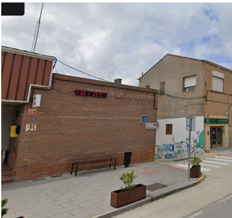
Fotografía del entronque del Camino "E" con la Avda. Autonomía de Aragón. El edificio de la derecha es el afectado por la alineación.
