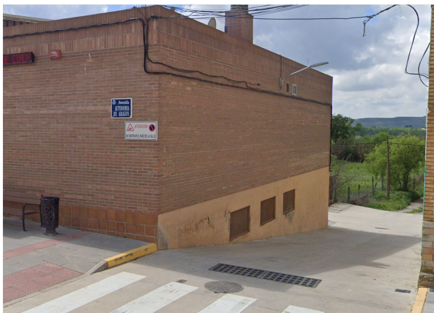
Fotografía del entronque del Camino "E" con la Avda. Autonomía de Aragón. El edificio de la izquierda es el equipamiento municipal.
