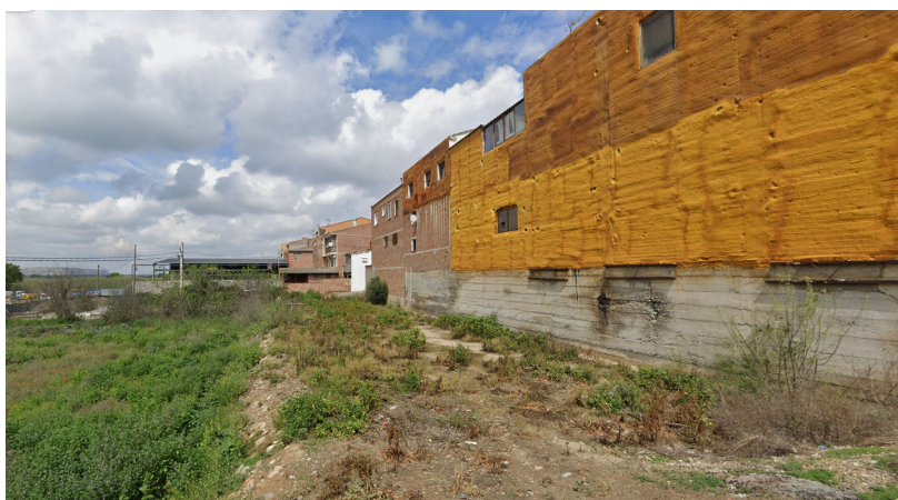
Fotografía de la parte posterior del edificio afectado por la alineación.
